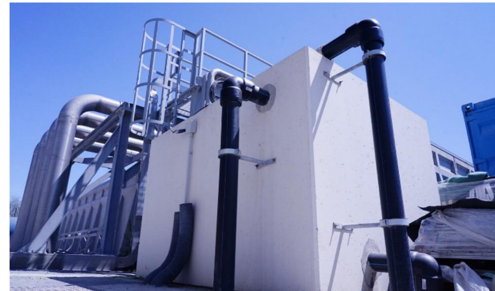
Nel 2018 SAPIR ha realizzato, inoltre, un **impianto per il recupero dei solidi** provenienti dalle acque di dilavamento dei piazzali di stoccaggio delle argille: si tratta, in altre parole, di un impianto di separazione dell'acqua e dell'argilla che permette di recuperare l'argilla stessa e riutilizzarla come materia prima.
